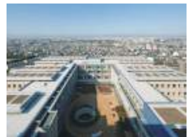
広場上からの外観
